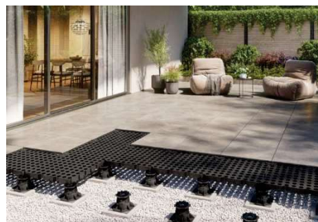
Im Bild: Platten 60 x 60 cm, im Verlegemuster der Boards. Je nach Plattenformat und Verlegemuster sind zusätzliche Stelllager erforderlich.
